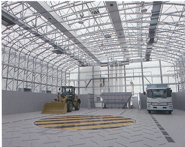
投入台船内部
