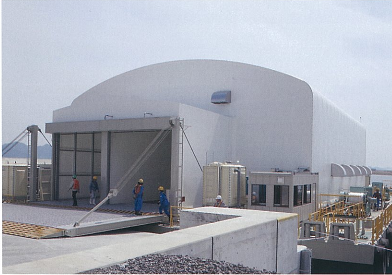
投入台船外観
