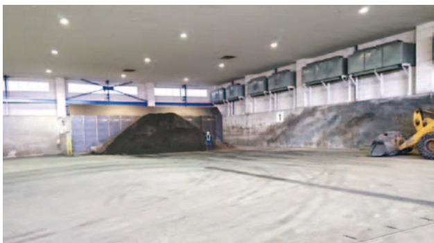
受入施設内部
